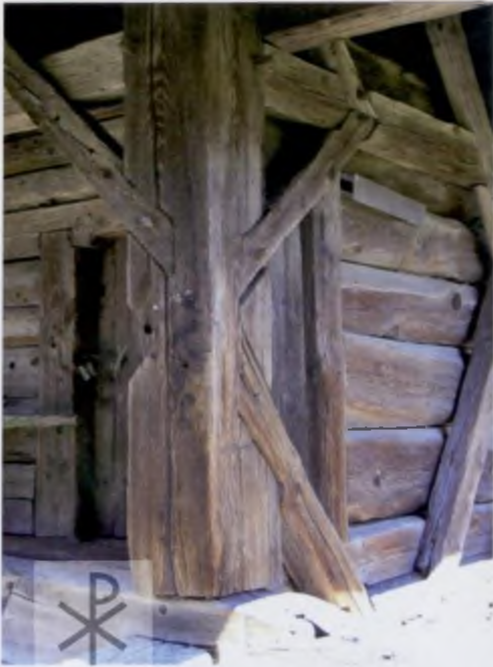
Фрагмент каркасно-стовпової конструкції будівлі (с. Вербляни Яворівського р-ну Львівської обл.). Світлина М. Глушка, 2006 р.
