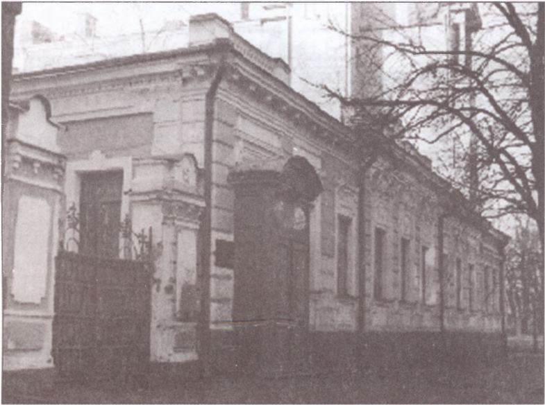
Колишній особняк по вул. Інститутській, 12. 1993 р.
