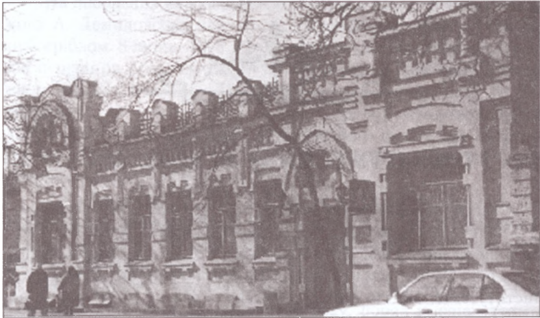
Колишній особняк по вул. Інститутській, 26. 1994 р.
