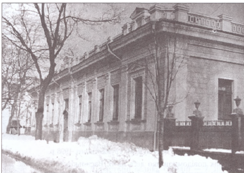
Фасад з боку вул. Шовковичної. 1994 р.
