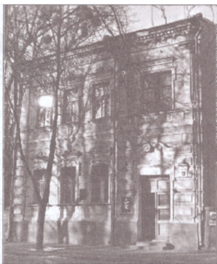
Фасад колишнього особняка М. О. Леопардова по вул. Липській, 10. 1993 р.
