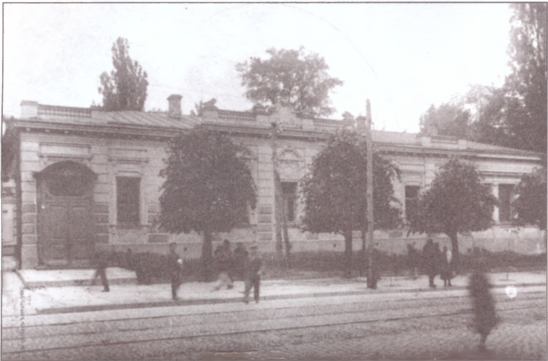
Колишній особняк по вул. Інститутській, 12. 1930 р.
