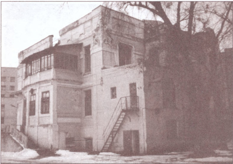
Колишній особняк по вул. Багговутівській, 14. 2000 р.
