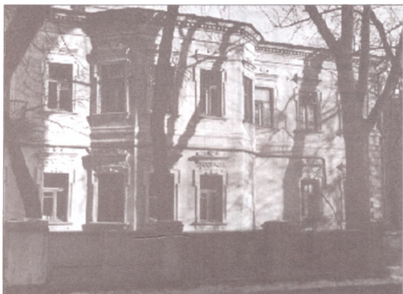
Бічний фасад колишнього особняка М. О. Леопардова по вул. Липській, 10. 1993 р.
