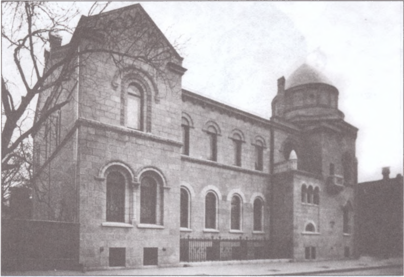
Фасад з боку вул. Шовковичної. 1914 р.
