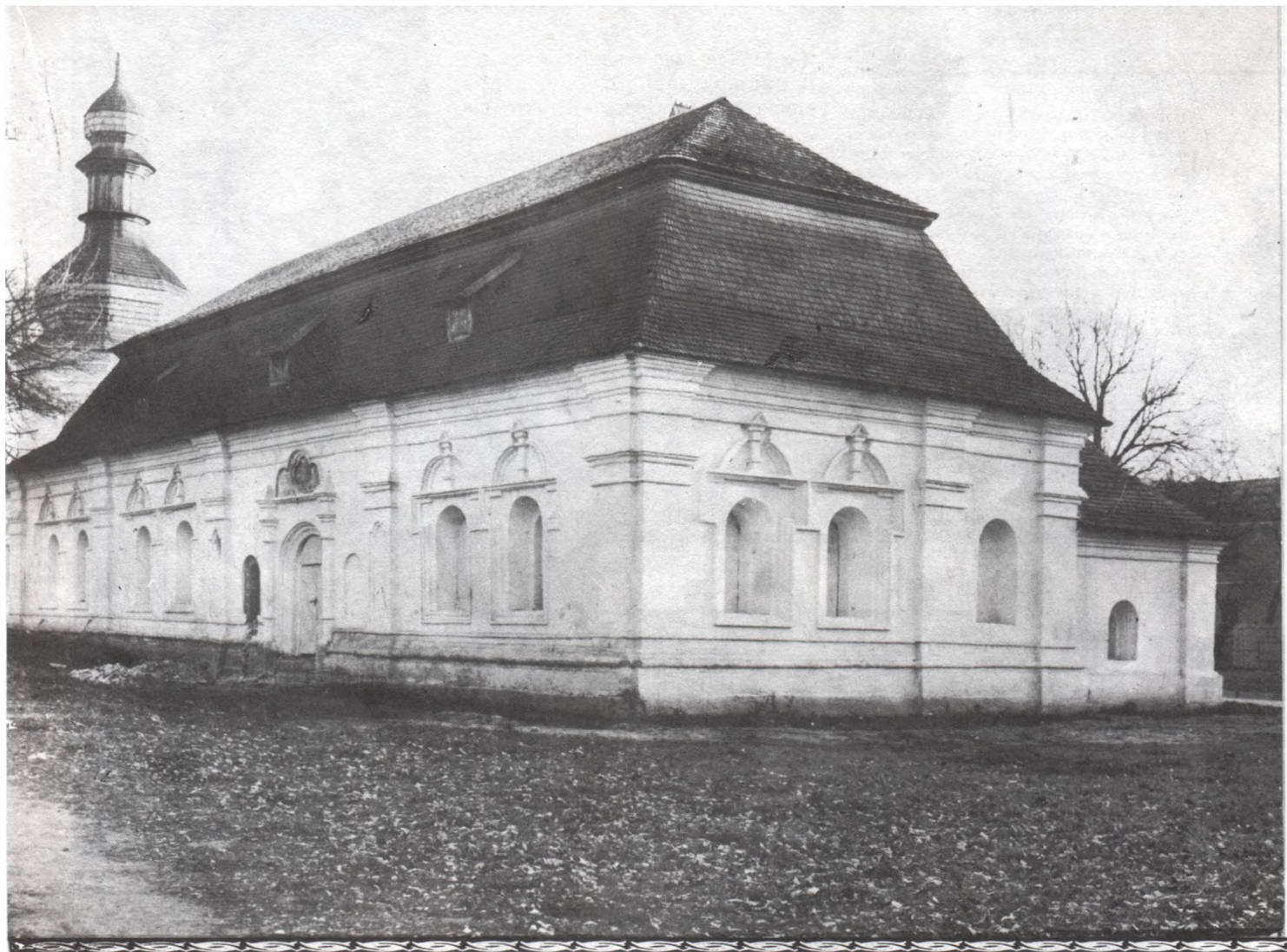
Вигляд з північно-західної сторони після реставрації
