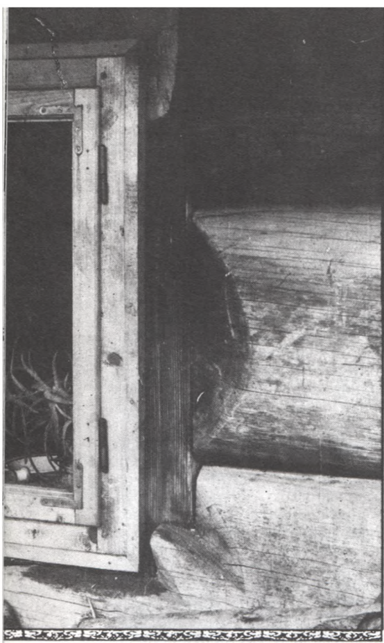
Приклад відтворення декору віконної коробки хати з с. Синьовирської Поляни: зацілілий вигляд; креслених відтворення вікна
