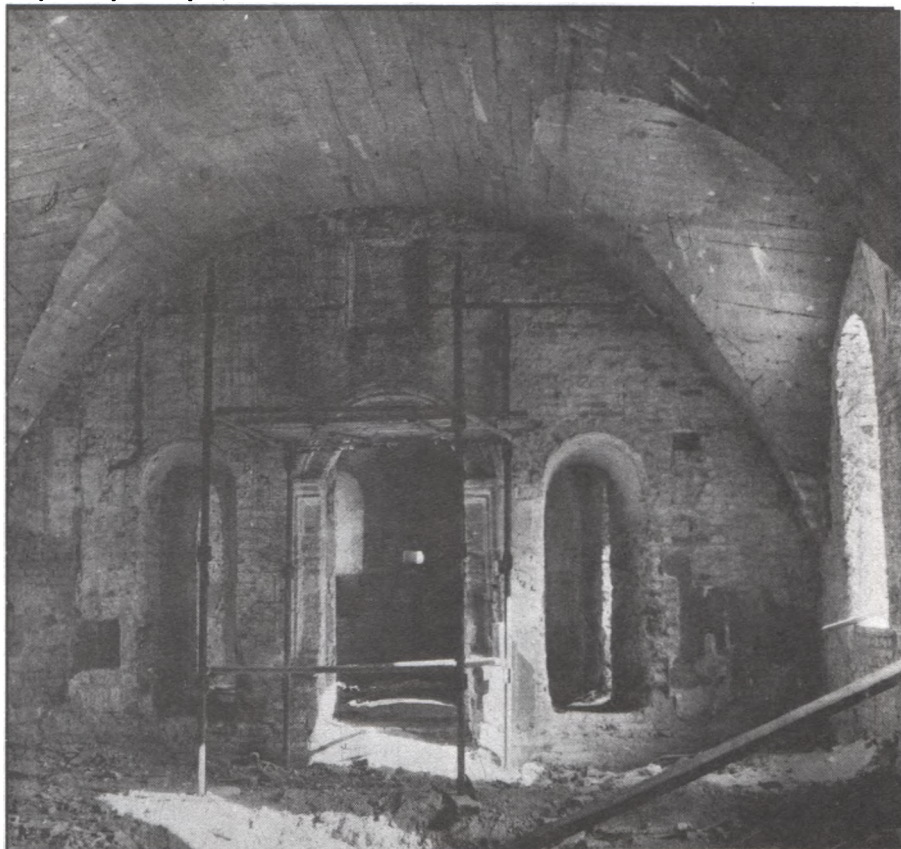
Зала трапезної в процесі реставрації
