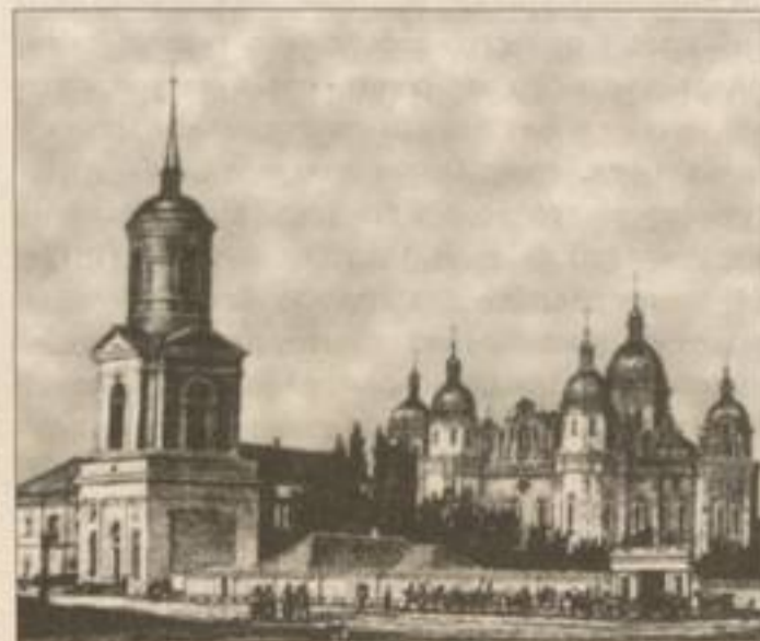
Будівля Київської духовної академії. Середина 19 ст.
