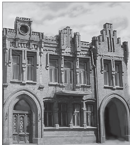
Будівля ДМШ № 1 ім. Генр. Нейгауза (м. Кропивницький)
