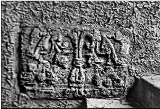
Дракон і орнамент на плитах Вежі Мурованої в Острозі. XIV ст.
