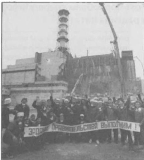
Бригада зі спорудження саркофага над четвертим енергоблоком.
