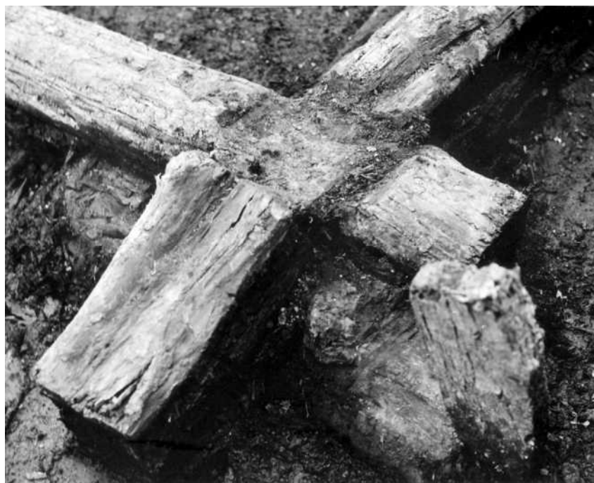
Фото 3. Звенигород. Північно-східний пригород. Зруб в “обло” з надлишком. Фото І. Свешнікова, 1983 р.
